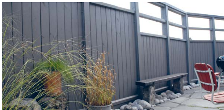
Skärm av trä och glas vid uteplats. Foto: Marie Lundqvist, Trafikverket.
