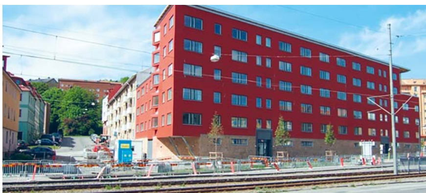
Kvarteret Örlen i Göteborg efter förtätning. Ny byggnad med genomgående lägenheter. Byggnaden minskade ljudnivån på gården med 6–10 dBA. Foto: Ljudlandskap för bättre hälsa.
