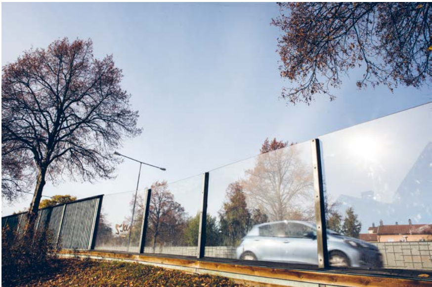
Genomsiktig bullerskärm invid väg. Foto: SKL.
