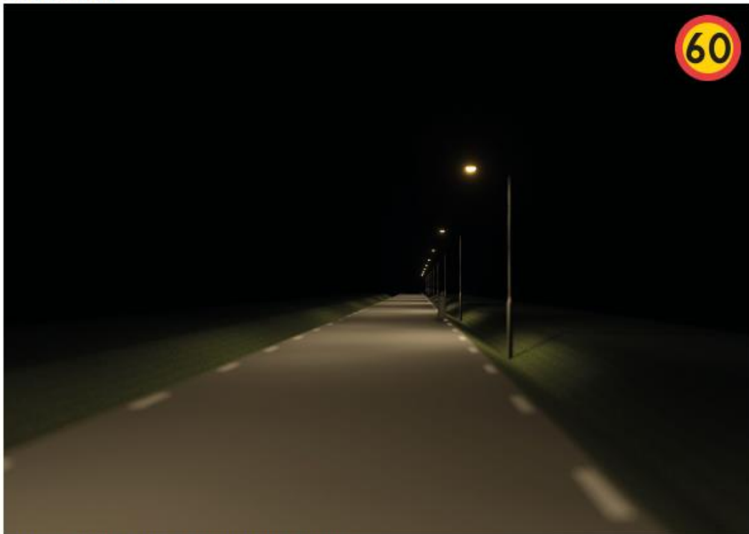
Modern anläggning, god luminans och jämnhet Mötande gångtrafikanter
