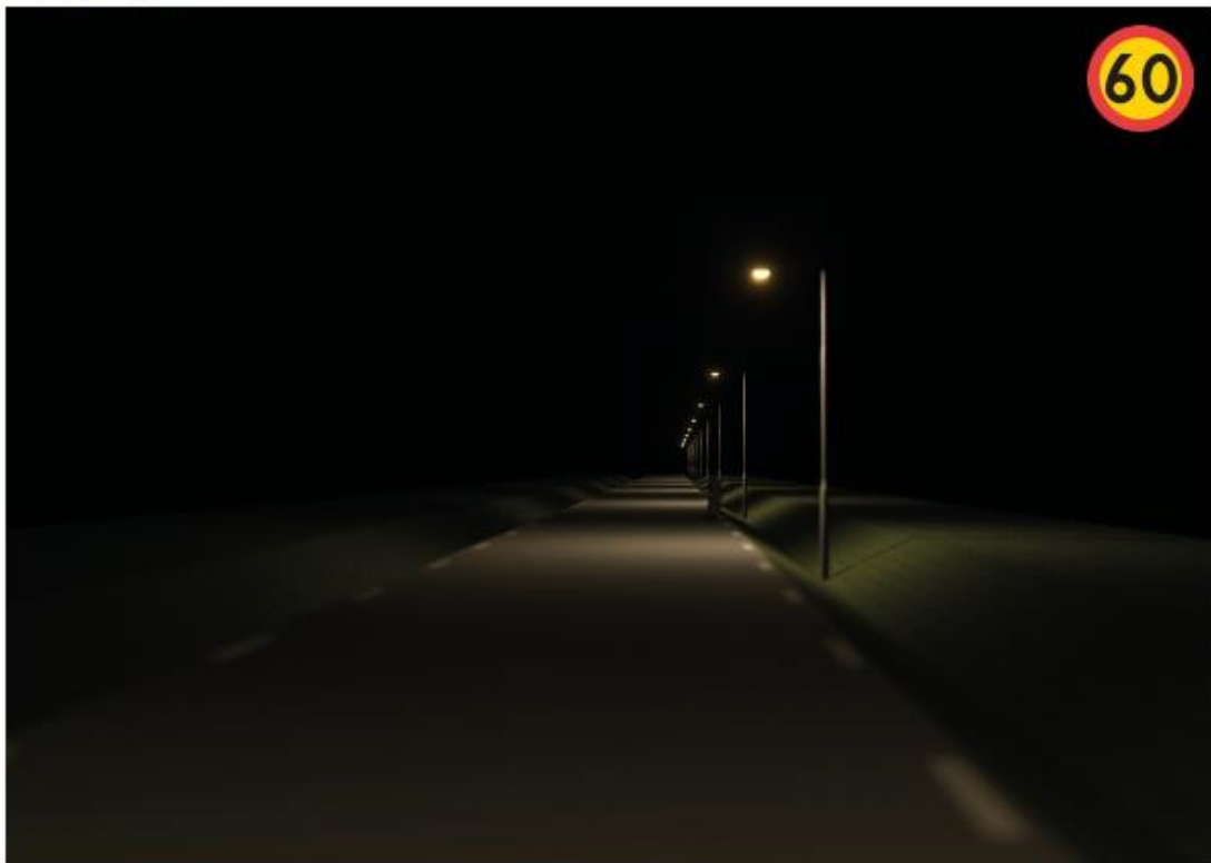
Illustration: Befintlig anläggning, bristfällig luminans och jämnhet Mötande gångtrafikanter
