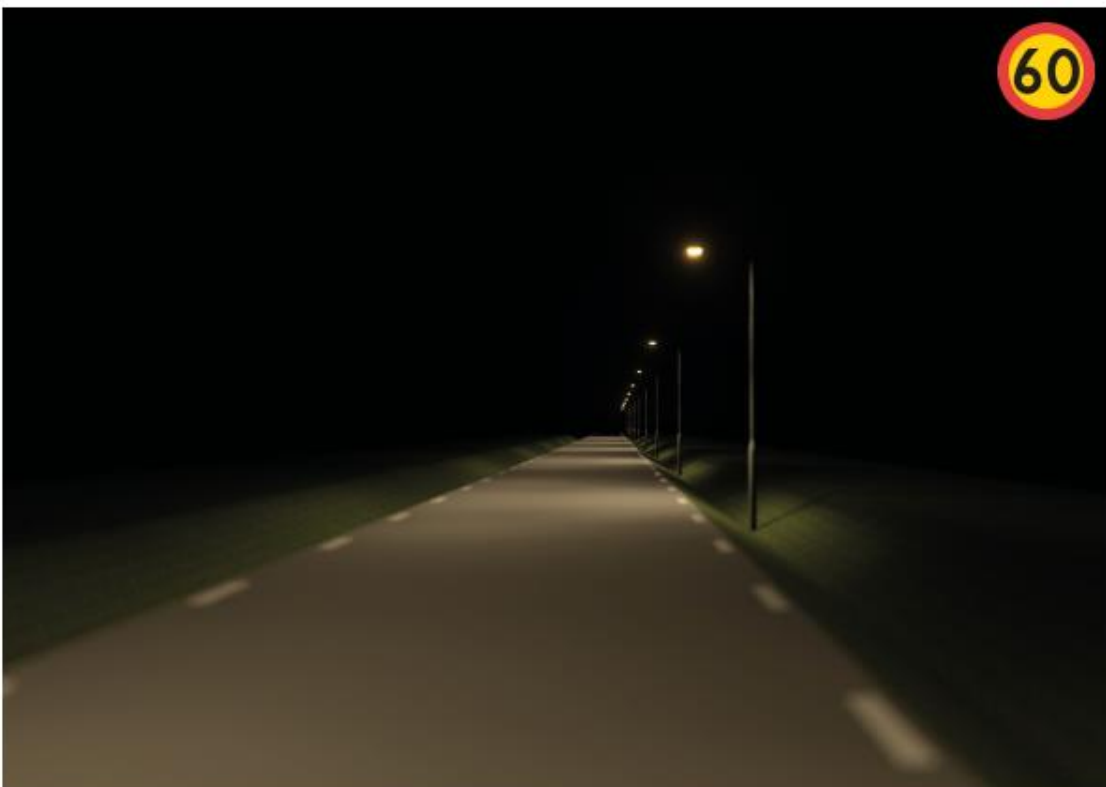
Illustration: Modern anläggning, god luminans och jämnhet på belysning
