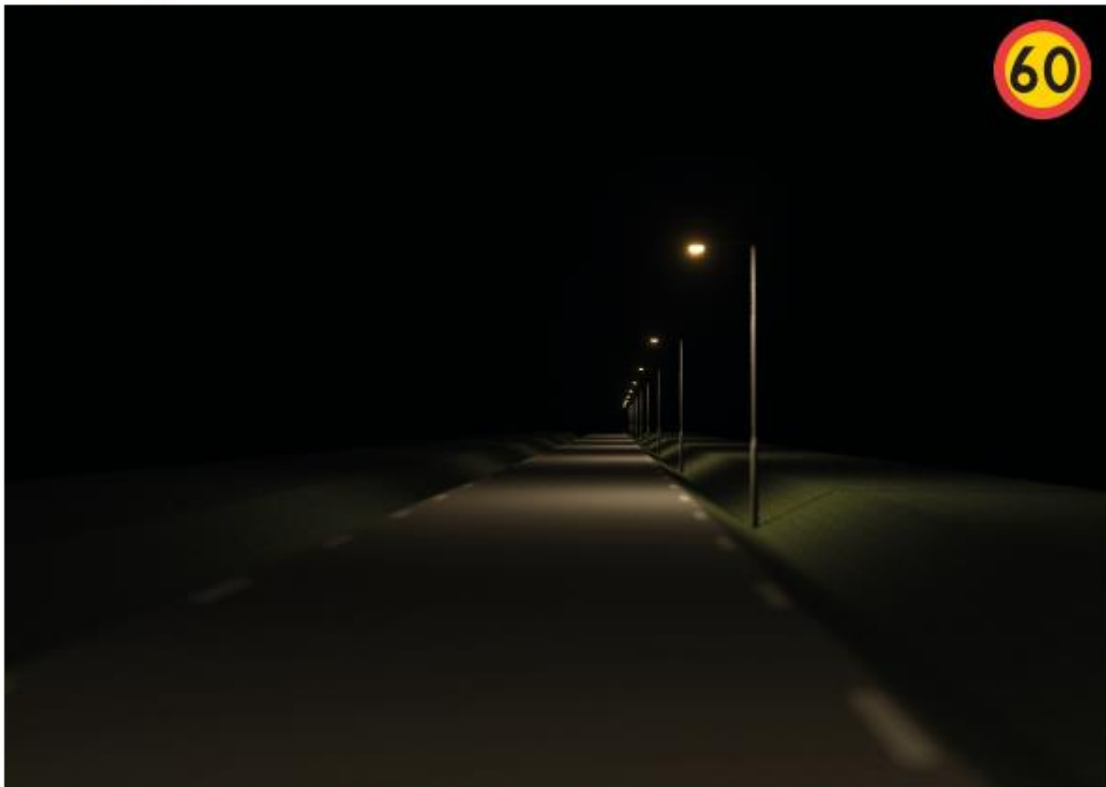
Illustration: Befintlig anläggning, bristfällig luminans och jämnhet på belysning
